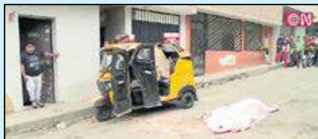
Vecino de El Ermitaño falleció al caerle parte de la pared de una vivienda
